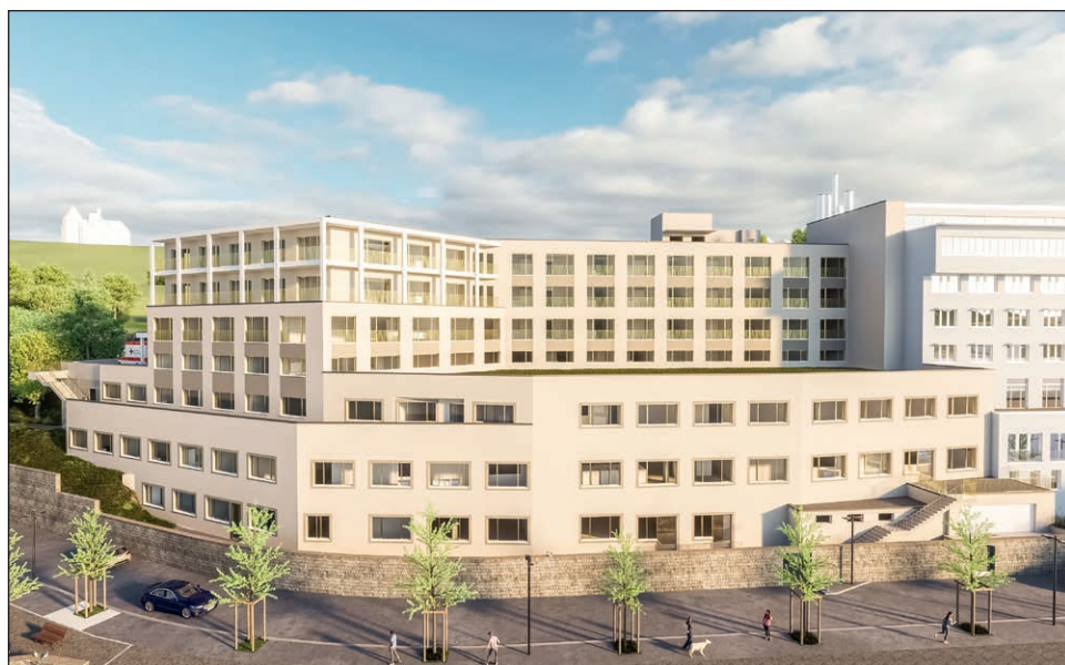
Abbildung 3: Der Trakt A+ bildet künftig das Herzstück des Klinikbetriebs. Er soll bis 2028 fertiggestellt sein. (Visualisierung)
