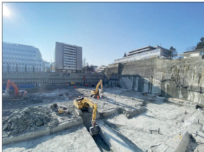
Blick in die Baugrube für den Neubau Kinderspital/Frauenklinik am Standort Luzern. Der Aushub ist grösstenteils abgeschlossen, mit den Erdsonden-Bohrungen wurde begonnen.
